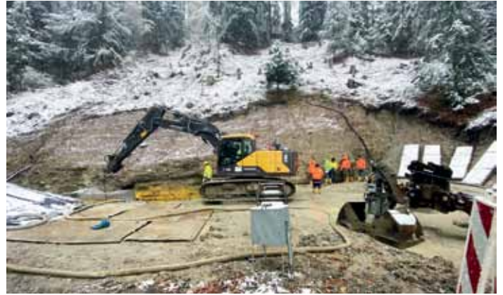
Aufnahme von der laufenden Baumaßnahme, Stand Ende November
