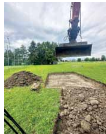
Hier entsteht das Fundament für den Naturkindergarten.
